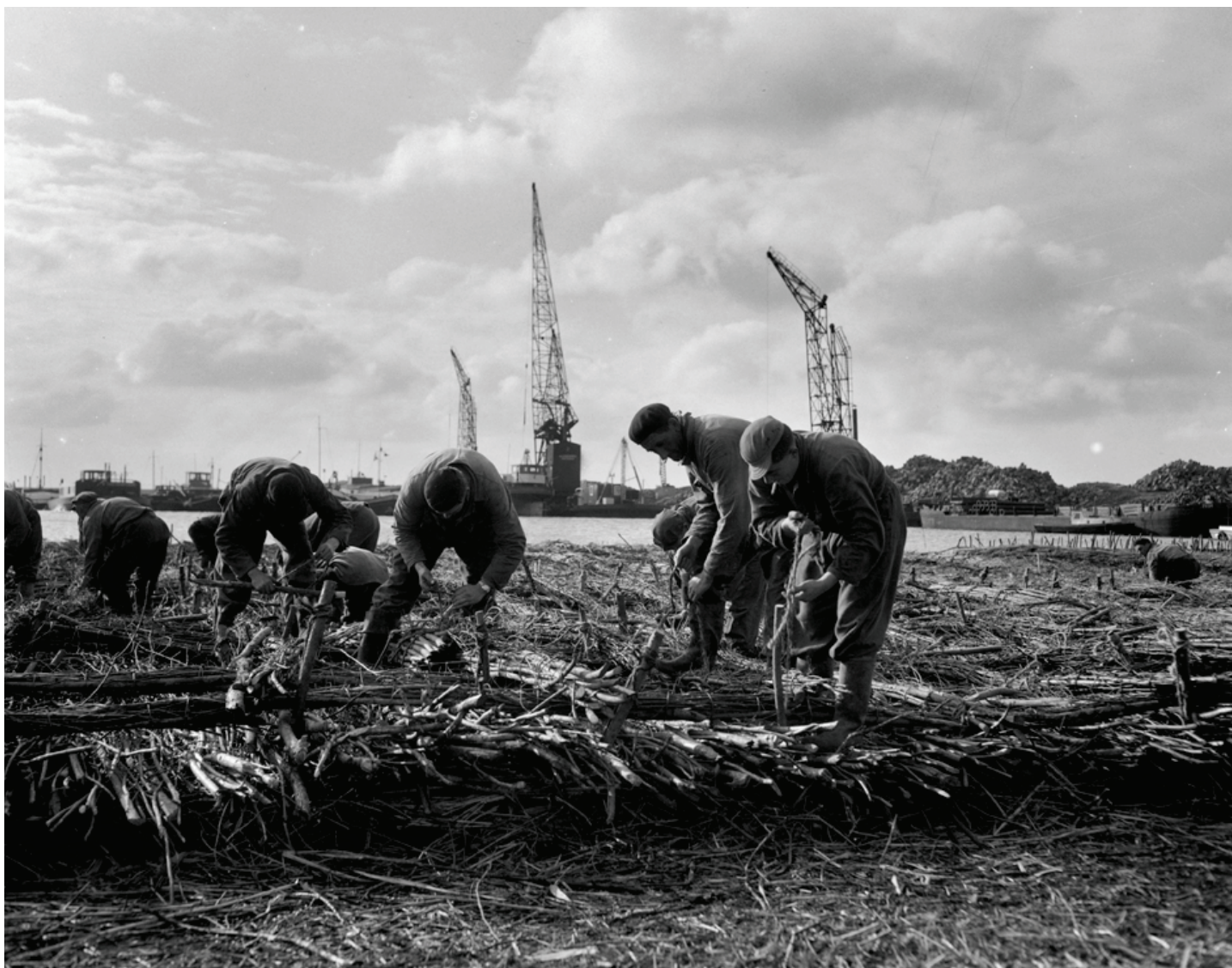
Arbeiders werken aan de afsluiting van het Haringvliet in 1956 | Wikimedia
